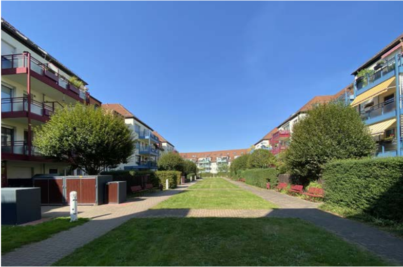
Kastanienring Blick Innenhof
